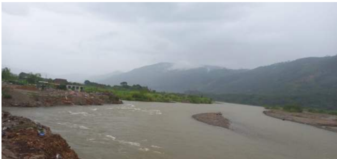
FIGURA N° 01: SE OBSERVA EL MATERIAL COLMATADO Y LA RIBERA DESPROTEGIDA EN LA MARGEN DERECHA DEL RIO PERENE.
